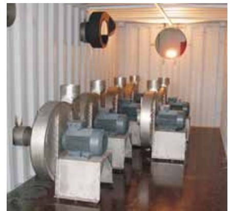
Lüfterstation im “Bauzustand”
